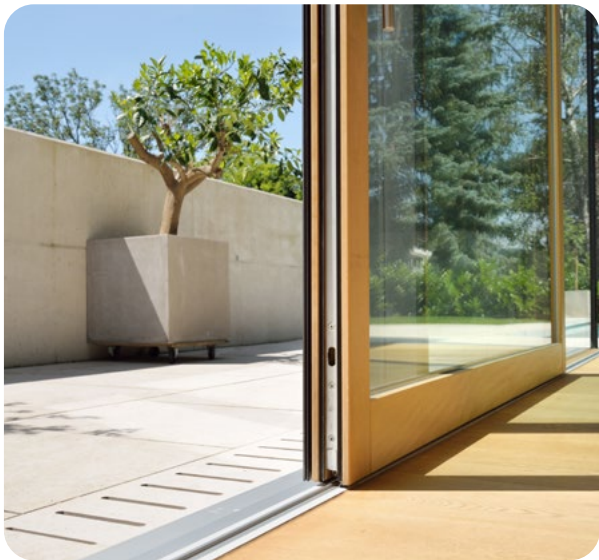
Hebeschiebetür – niveaugleiche Schwelle
