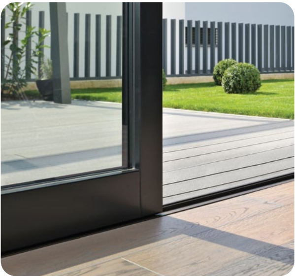
Hebeschiebetür – niveaugleiche Schwelle (Bodendielen)
