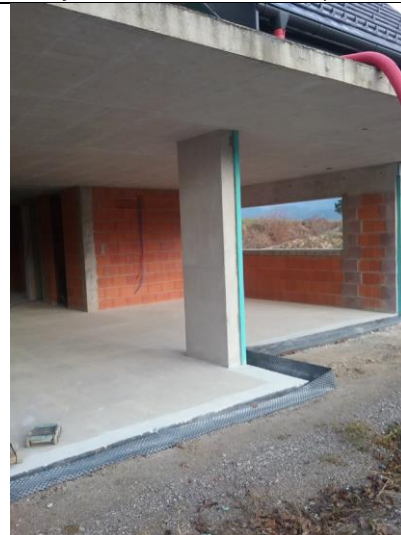
Pripravljene okenske odprtine
