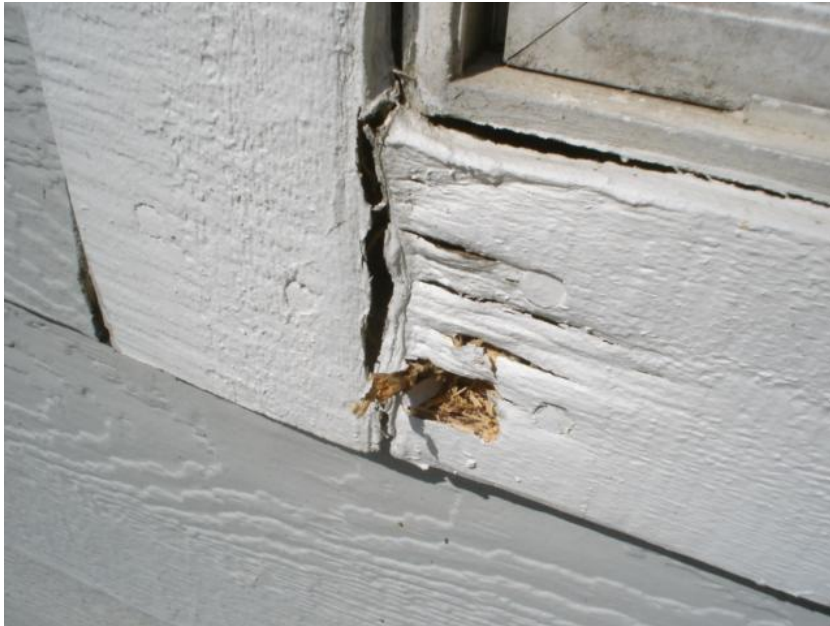
Primer trohnenja kotnega okenskega spoja
