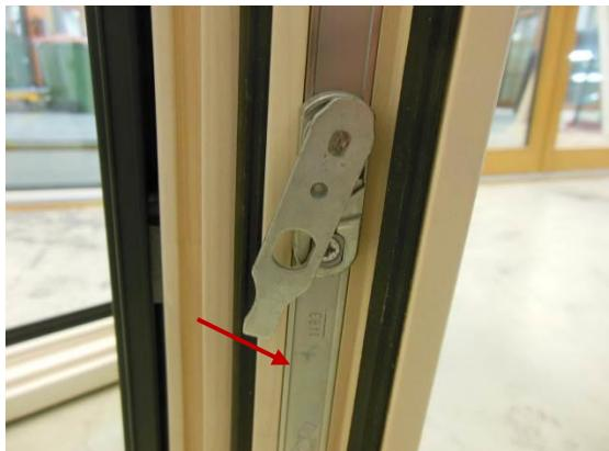
Slika 36: prestavitev nivojnega varovala v vertikalni položaj
