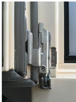
Abb. 25: Der Anpressdruck des Flügels auf den Rahmen (untere Türangel)
