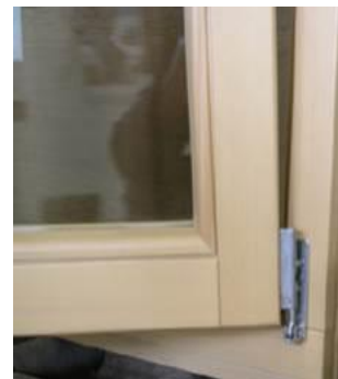
Abb. 34: Ausheben des Flügels
