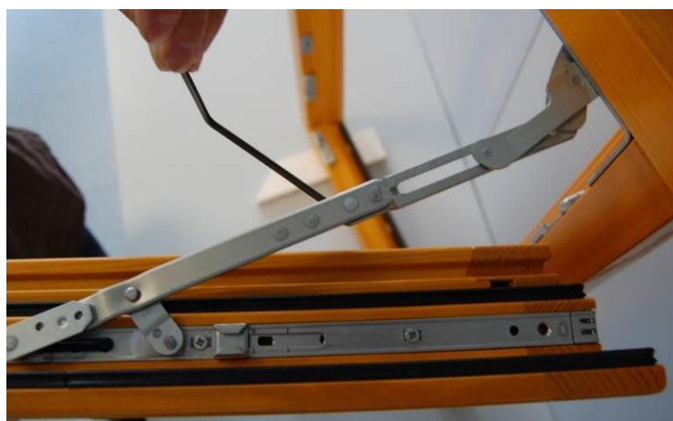
Abb. 37: Wegrücken des Flügels vom Rahmen (oben)
