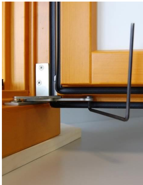
Abb. 38: Wegrücken des Flügels vom Rahmen (unten)
