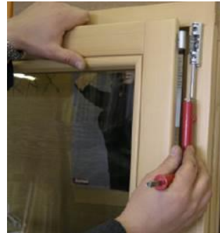
Abb. 33: Herausziehen des Bolzens
