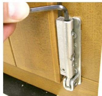
Abb. 24: Höhenverstellung der Fenster (untere Türangel)
