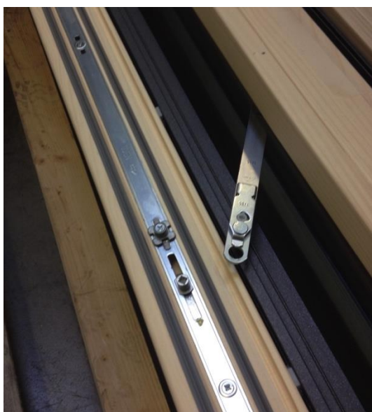
Abb. 50: Aushaken der Schere durch Hochziehen
