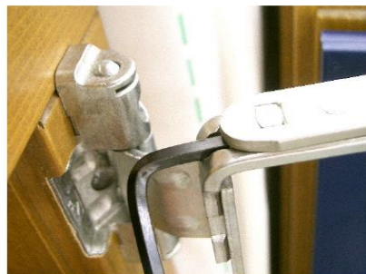
Abb. 27: Horizontale Verstellung des Fensters (obere Türangel)
