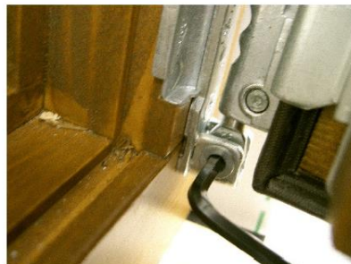
Abb. 26: Horizontale Verstellung des Fensters (untere Türangel)
