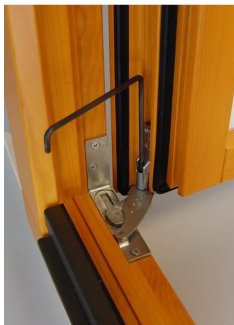
Abb. 39: Höheneinstellung des Flügels
