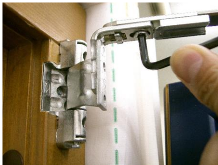
Immagine 28: Aderenza della parte superiore dell'anta (cerniera in alto)
