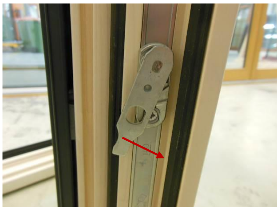
Immagine 40: Spostamento della protezione del livello in posizione verticale
