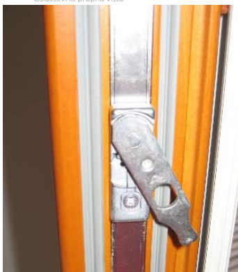
Immagine 2: Immagine di limitatore d'apertura
