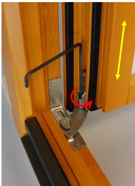
Immagine 39: Regolazione dell'altezza dell'anta
