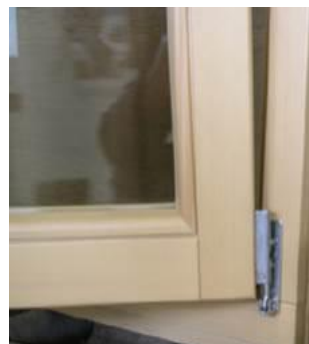
Immagine 34: Smontaggio dell'anta
