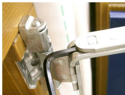
Immagine 27: Spostamento orizzontale della finestra (cerniera in alto)
