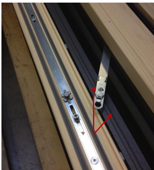
Immagine 50: sganciamento della forbice con trazione all'insù
