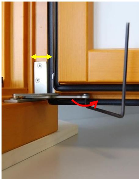
Immagine 38: Rimozione dell'anta dal telaio (in basso)
