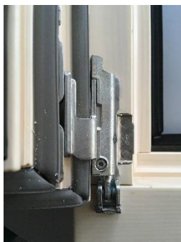
Immagine 25: Aderenza dell'anta al telaio (cerniera in basso)
