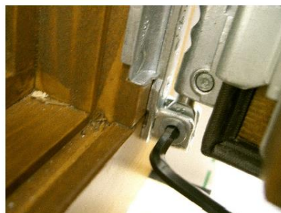
Immagine 26: Spostamento orizzontale della finestra (cerniera in basso)
