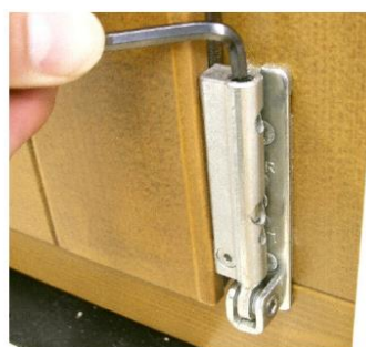
Immagine 24: Regolazione della finestra in altezza (cerniera in basso)
