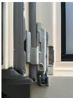
Image 25: Pression dans le battant du cadre de la fenêtre (gond inférieur)
