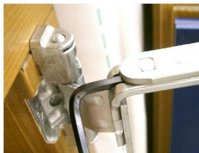
Image 27: Mouvement horizontal de la fenêtre (gond supérieur)
