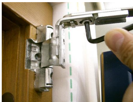
Image 28 : Jointure de la partie supérieure de la fenêtre (gond supérieur)
