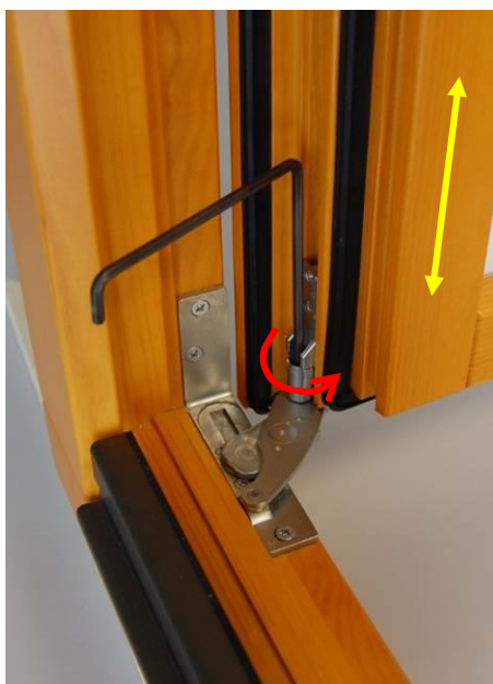
Image 39: Réglage de la hauteur du battant
