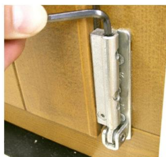
Image 24: Pose de la fenêtre dans le sens de la hauteur (gond inférieur)
