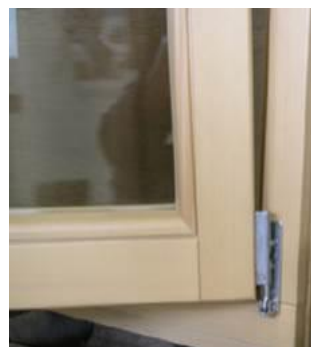
Image 34: Détachement du battant
