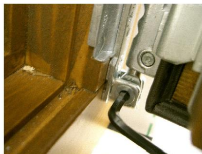
Image 26: Mouvement horizontal de la fenêtre (gond inférieur)
