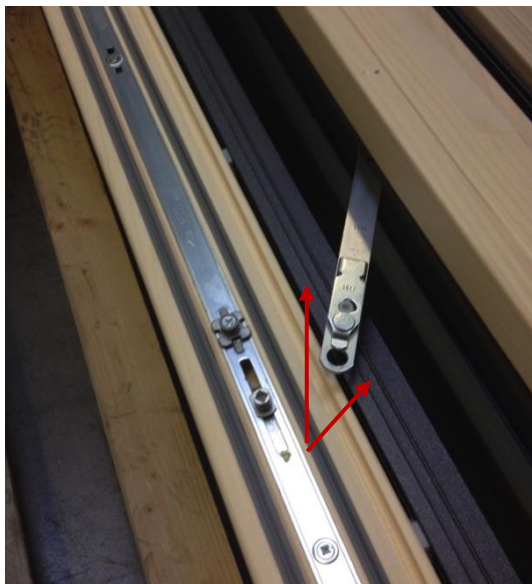
Image 50: Relâchement des ciseaux en tirant
