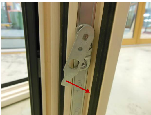
Image 40: Déplacement de la crémone en position verticale
