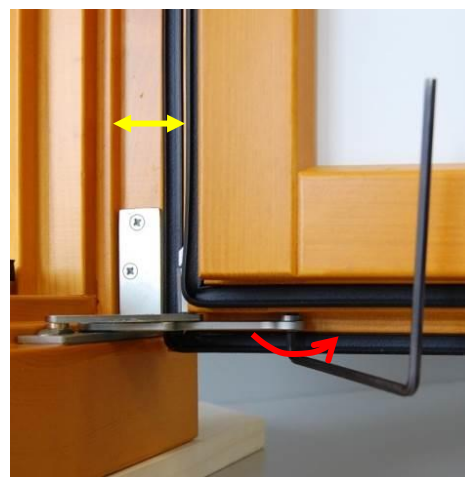
Slika 34: odmikanje krila od okvirja (spodaj)
