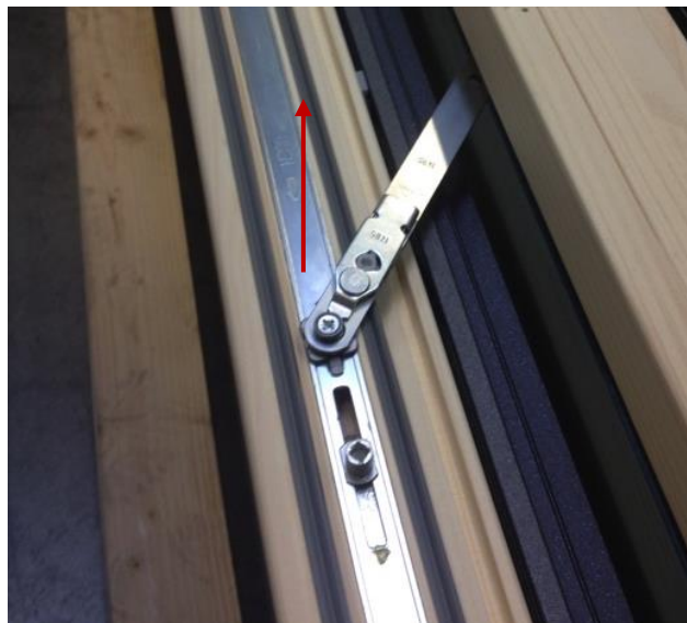
Slika 44: Sash scissors
