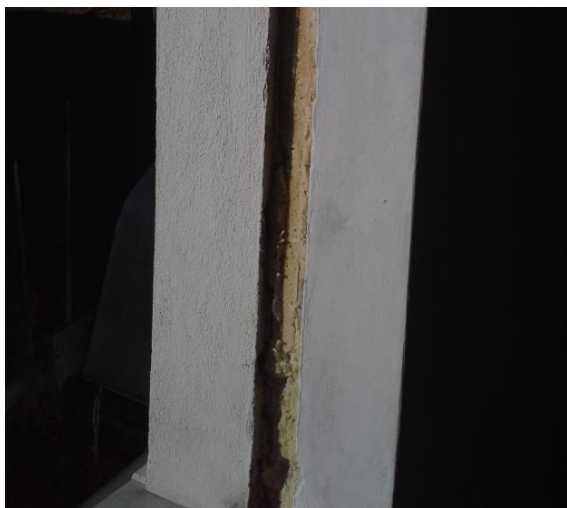
Pravilno pripravljena okenska odprtina (prenova)
