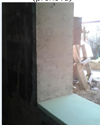
Pravilno pripravljena okenska odprtina (novogradnja)
