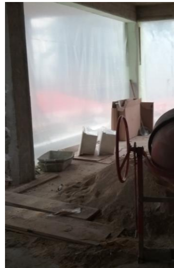
Nezgledno pripravljen prostor za izmero (Novogradnja)
