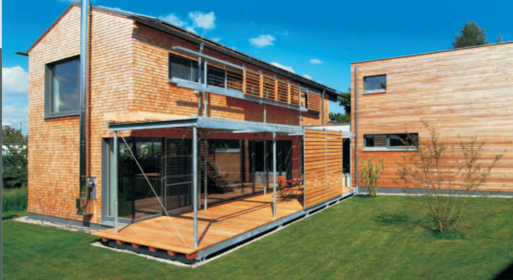
VETRO-V7 Les hrast / barva DH1 Steklo stopsol supersilver grey / emalj črni Prijemalo GR180 / kljuka GE504Z Stranski element V100 U_{D(vrata\ in\ stranski\ element)} 1,4 W/m 2 K
